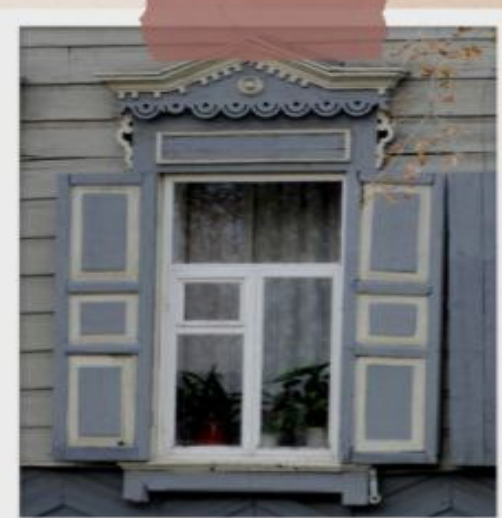
ул. Карла Либкнехта, 5
