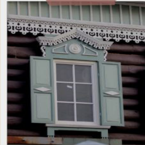
ул. Карла Либкнехта, 18
