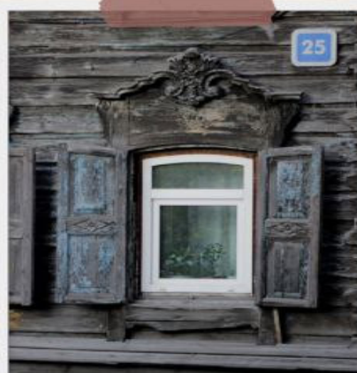
ул. Карла Либкнехта, 25
